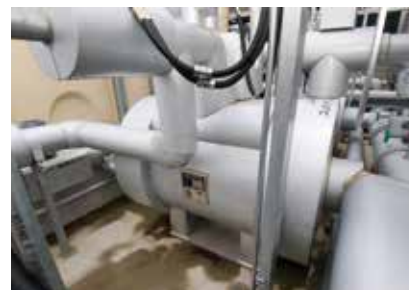
排温水が直接ヒートポンプに流れ込まないように縁切りを目的としたスパイラル熱交換器
