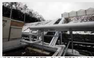
冷温水配管 (手前:熱源機・タンク、写真右上:ハウス)
